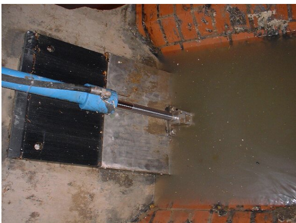
Abbildung 7: Einstau des Spülvolumens
