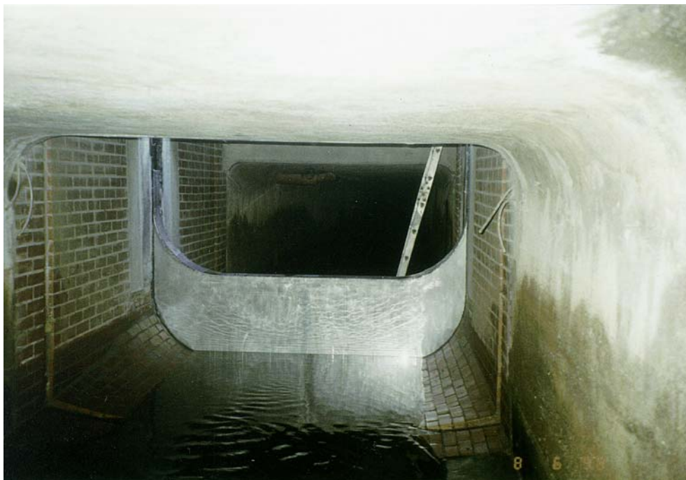
Bild 2: Kaskadenwehr, Mainz, Wehrposition Mitte
