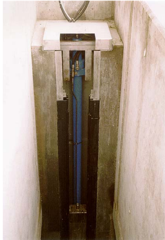
Bild 7: Schaltschrank, Hydraulikaggregat und Hydraulikzylinder
