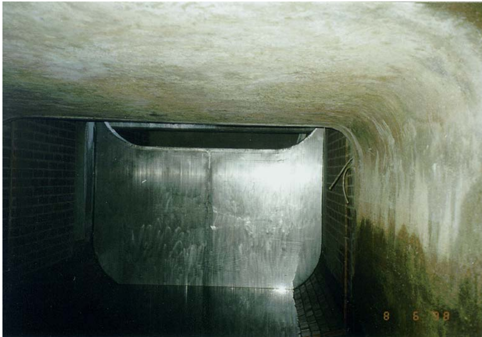
Bild 1: Kaskadenwehr, Mainz, Wehrposition oben
