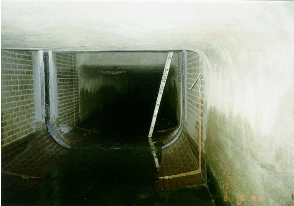
Bild 3: Kaskadenwehr, Mainz, Wehrposition Sohle
