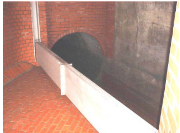
Doppelschieber-Bauwerk, Spaichingen
